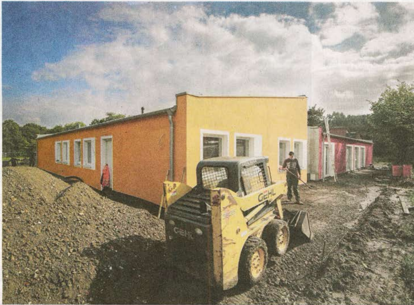
Waltrops neueste Kita am Funkenbusch ist noch eine Baustelle. Die ist aber gut im Plan, wie Andreas Westhoff von der Lebenshilfe erklärt. Der Estrich trocknet gerade, Fliesenleger und Deckenkonstrukteure sind am Werk, und gestern ist damit begonnen worden, die Hausanschlüsse zu verlegen. Im Januar sollen die Kinder hier einziehen. —FOTO: KALTHOFF
