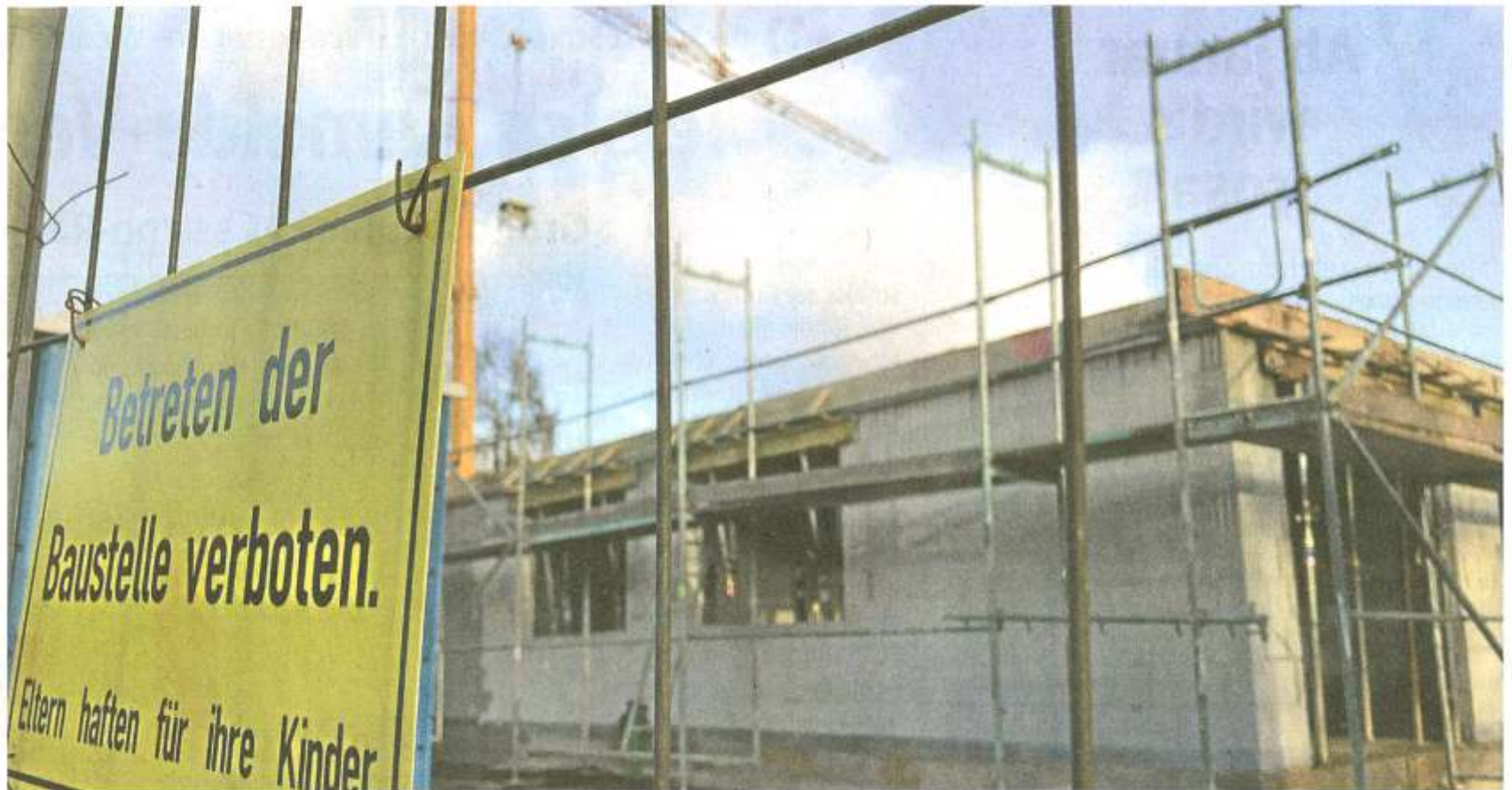
Die Baustelle in der Mark ist nicht zu übersehen. Dort entstehen Wohnungen für Menschen mit und ohne Behinderung.
